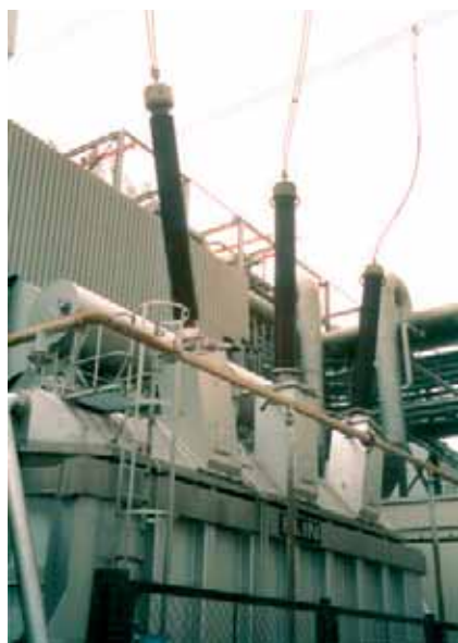
Bild 6. Faseroptische Temperaturmessung an der Stromdurchführung eines Transformators
